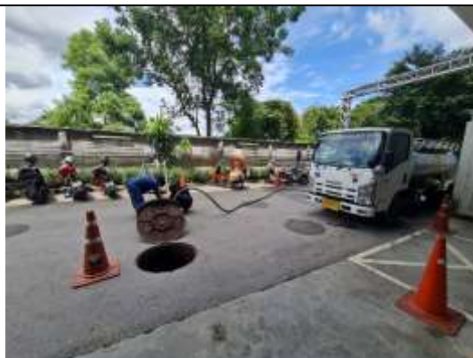
รูปที่ 2-13 การสูบน้ำจากบ่อบำบัดน้ำเสีย
